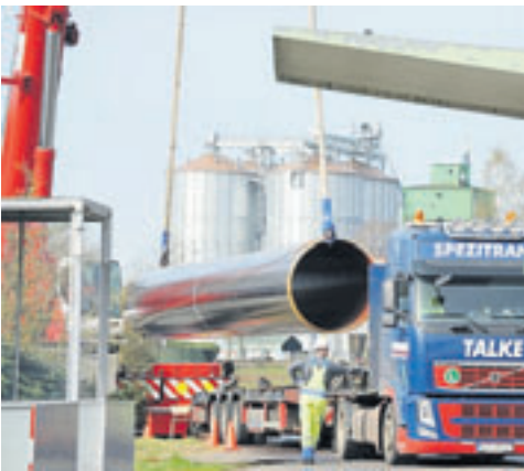
Vom Bahnhof Harpstedt aus werden die Rohre per Telesattel zu Sammelplätzen in unmittelbarer Nähe der Baustrecke gebracht – immer eins pro Zugmaschine, mehr geht nicht.
