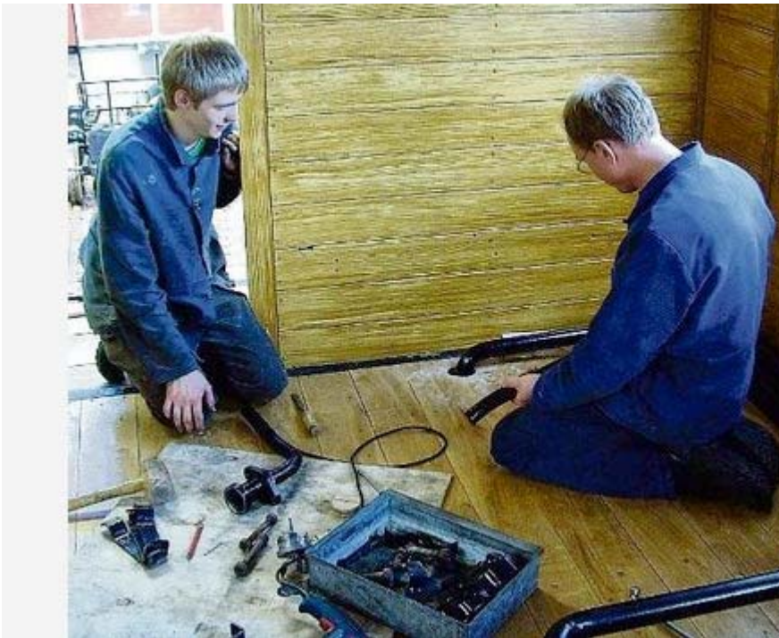
Thorsten Bächler und Torben Kluwe verlegen Dampfheizungsrohre im Plattformwagen Nummer drei. Das kleine Bild zeigt eine der eingepassten Sitzbänke.
