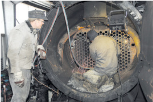
Schuften „wie die Kesselflicker“: Werkstattleiter Torben Kluwe (l.) und die Mitarbeiter einer Krefelder Fachfirma erneuern 270 Rohre im „Bauch“ der Lok. FOTO: Thorsten Konkel
